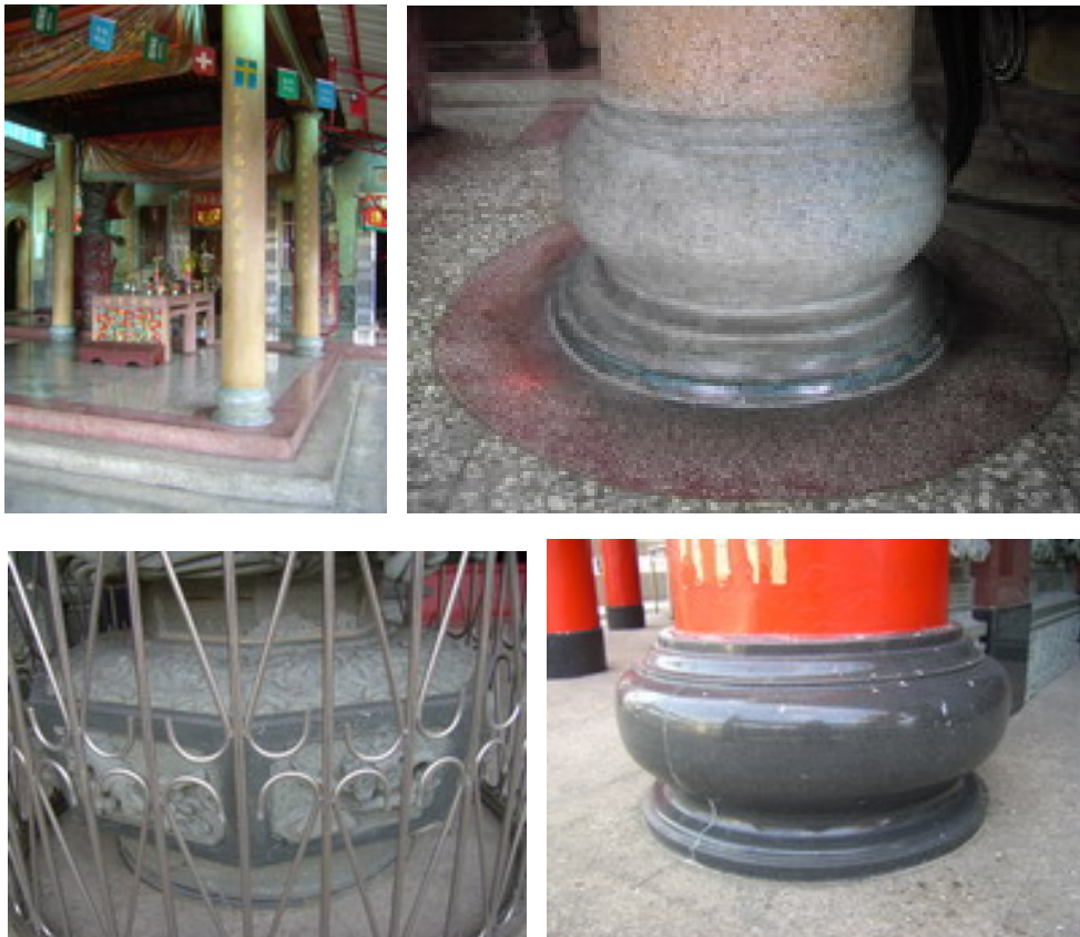
圖 21 竹田鄉頭崙村（上排）與內埔鄉富田村（下排）兩座國王宮的柱珠
