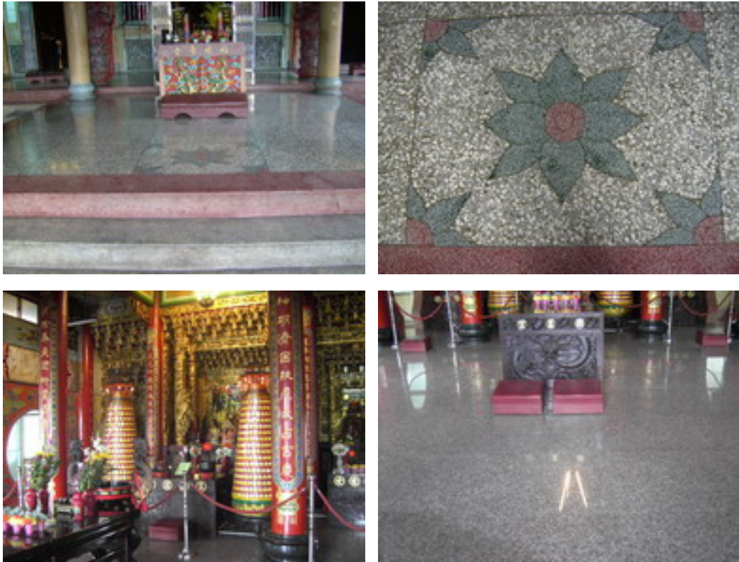
圖 12 竹田鄉頭崙村（上排）與內埔鄉富田村（下排）兩座國王宮的地面
