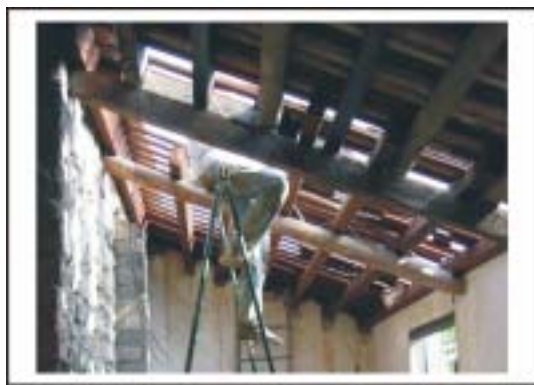
圖 4.25 下舍屋頂開口
