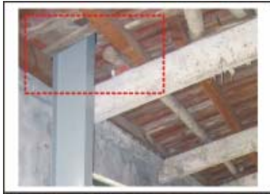
圖 5.26 原瓦片屋頂開挖之孔洞
