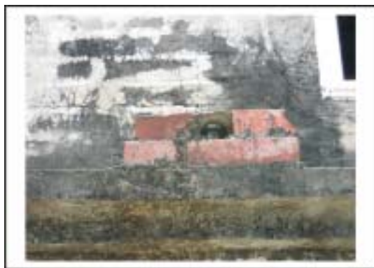
圖 4.40 利於支撐棚架的木條插入之孔洞
