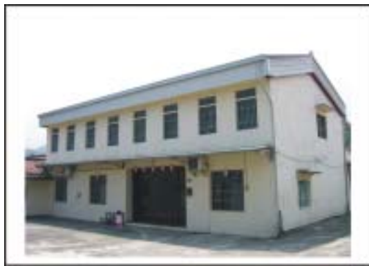
圖 5.25 原瓦片屋頂上方搭建鐵皮斜屋頂
