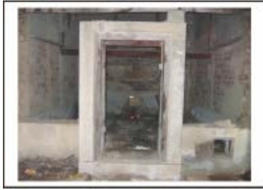
圖 4.49 土磚拆除後的本灶壁體 48
