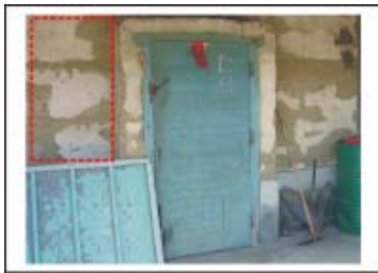
圖 5.16 土埆表面塗抹石灰
