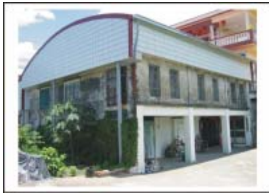
圖 5.27 原瓦片屋頂上方搭建鐵皮圓拱形屋頂
