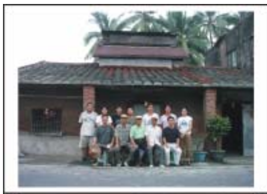
圖 5.48 馮彩彬菸樓修復完成
