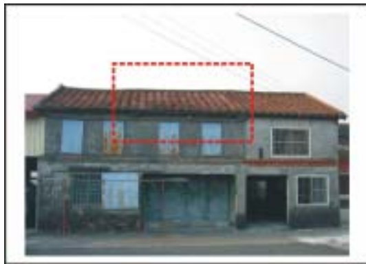
圖 5.23 拆除小屋頂後重新鋪設瓦材
