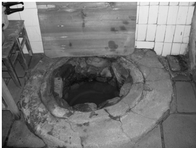
附圖 4 土樓大灶內附水井
