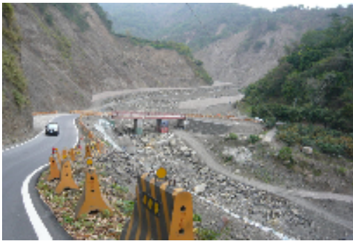
圖 5-17：六龜往桃源道路一隅，原本綠油油的山坡已經滿目瘡痍。
