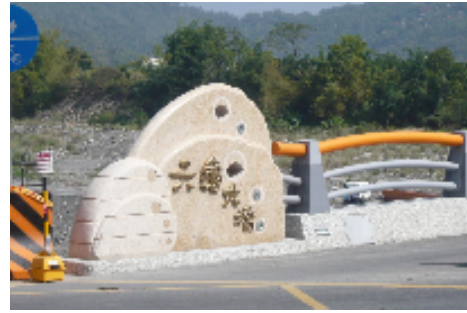
圖 5-16：新建完工的六龜大橋。
