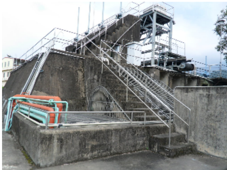
圖 3-2：日治時期所興建的「土壠發電廠」，目前仍持續運轉中。
