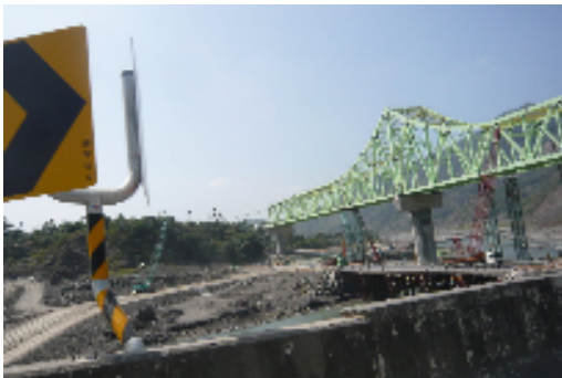
圖 5-21：荖濃溪上之斷橋，已重新改建鋼骨鐵橋。
