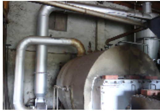
圖 2-10：密閉的鍋爐，透過高溫水蒸氣將小木片蒸熟。
