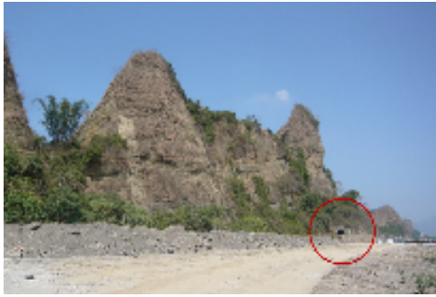
圖 5-15：88 羅漢山邊的六龜隧道外環道沖毀，紅色圓圈為日治時期所建的六龜隧道。
