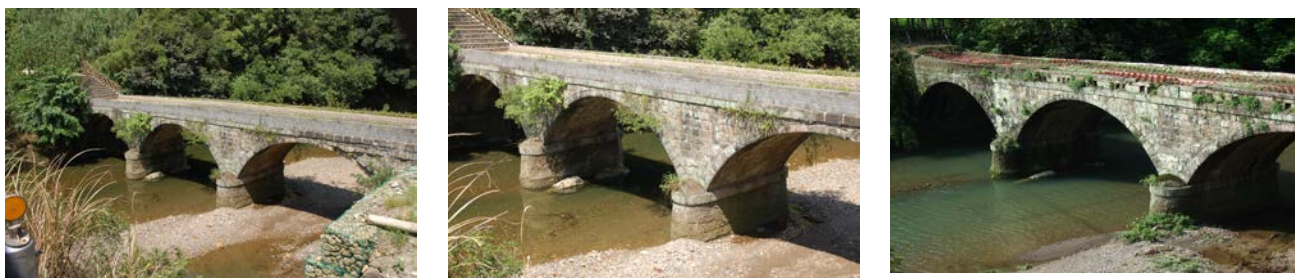
圖 08、本計畫實地勘查關西鎮之老橋（資訊指標）。
