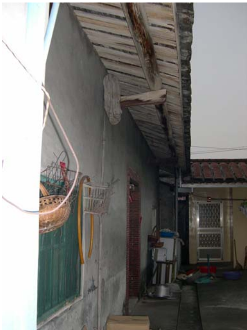
老宅院結構 3 土角磚外抹白灰牆
