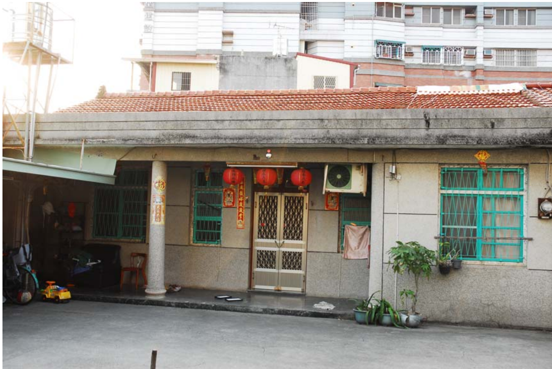
圖 64：田寮邱家的後面興建樓房，形成新舊對比（黎鴻彥攝）
