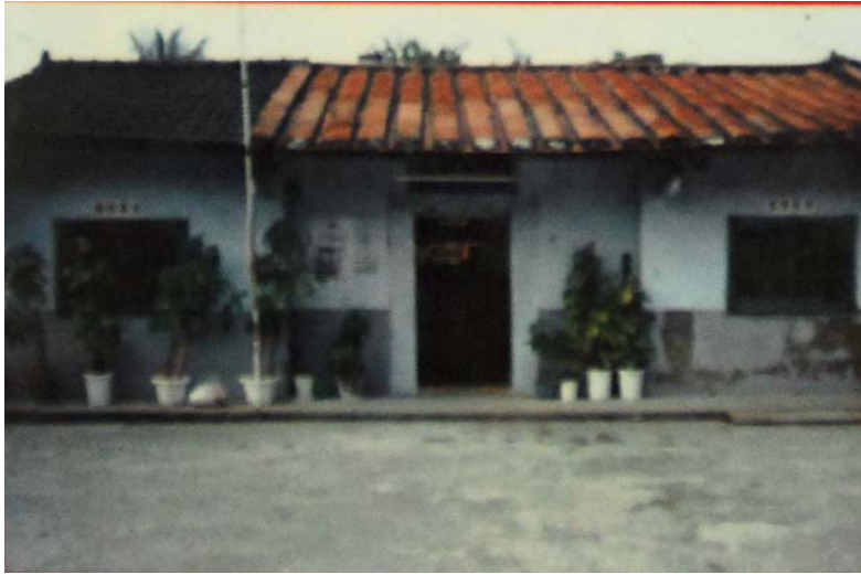
圖 56：座落田寮的邱元奎宅拆除前留影（黎鴻彥翻攝）
