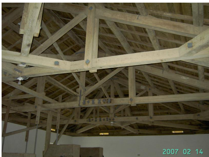
圖 3-5 穀倉屋頂的木造結構。
