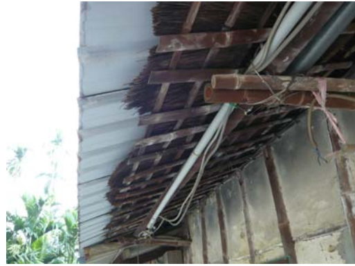
圖 4-3：穿鑿屋的屋頂用茅草覆蓋，然而現在又加上鐵皮，以防止漏水。
