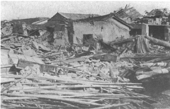
圖 2-5：銅鑼車站附近的倒塌房屋
