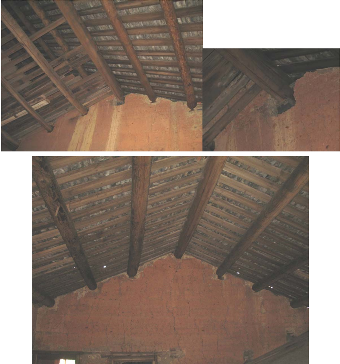
圖十二 永定高陂裕隆樓後樓屋頂 筆者自攝
