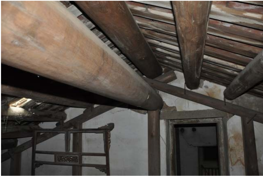
圖四 臺中后里張天機宅正廳閣樓梁架 李慧貞攝
