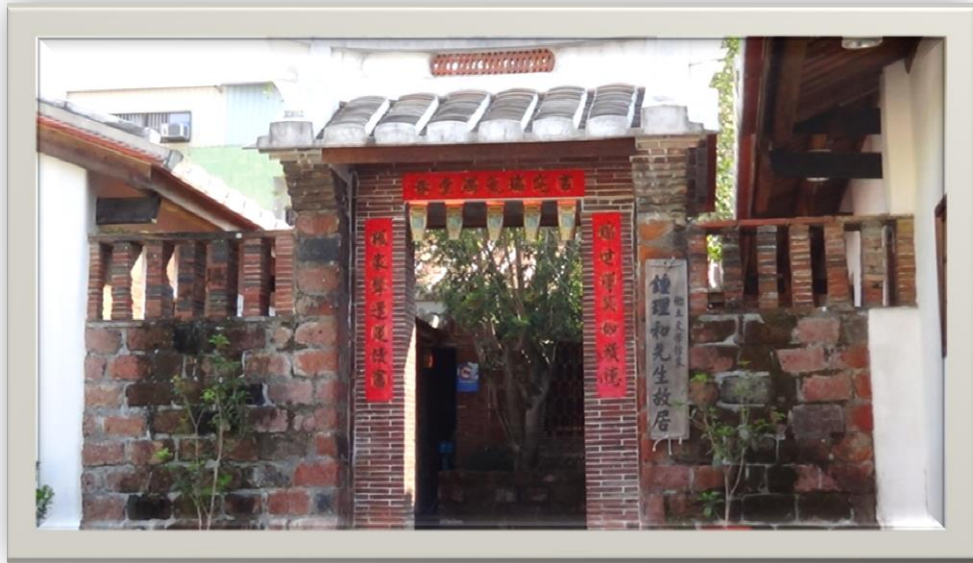
鍾理和故居整修後現況(撰者拍攝 2013.10)
