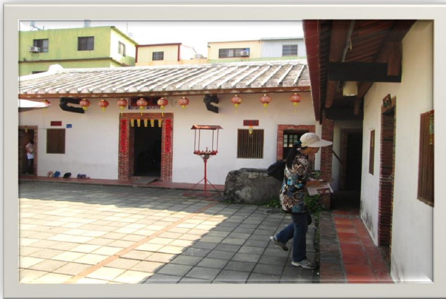
鍾理和故居整修後現況(撰者拍攝 2013.10)
