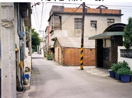
2001 年聚落內景觀（加強磚造樓房占多數）
